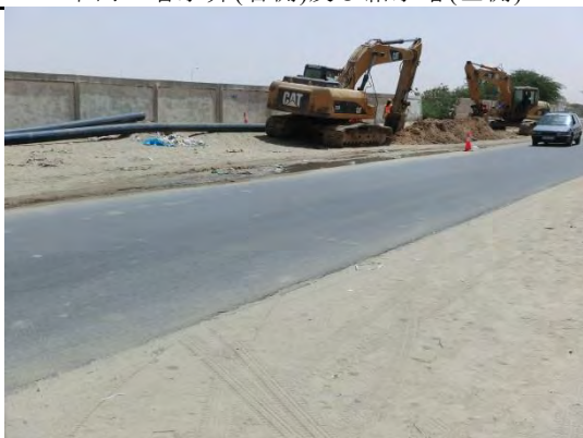
市内の配水網改修プロジェクト
