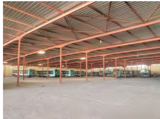
公共交通公社 (STP) の屋根付きのバス駐車。ルノーの中古車を使用されている
