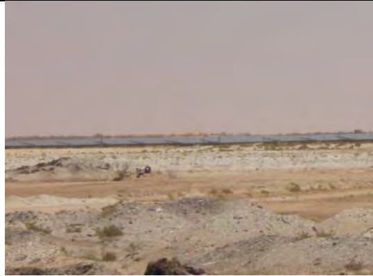
ヌアクショット市北部で建設中の太陽光発電所 (15MW)
