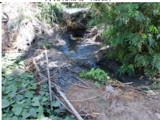
処理場からの処理水の流入口
