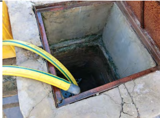
水位の低い貯水槽(Sebkha 地区)
