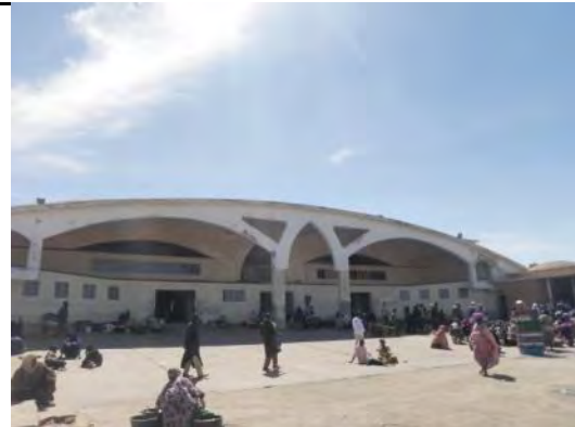
日本の無償資金協力で整備された漁市場。 小売店、魚のさばきスペース等が、整備されて いる
