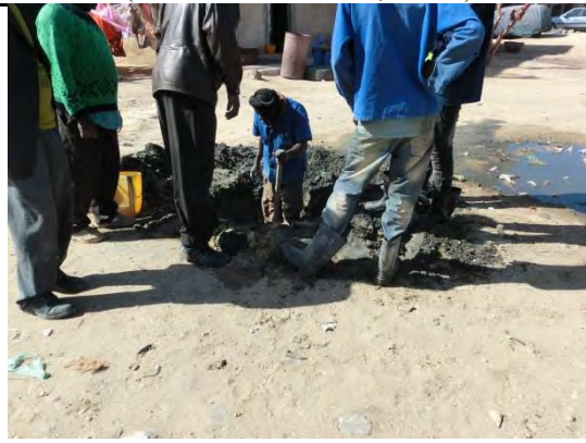
配水管漏水補修
