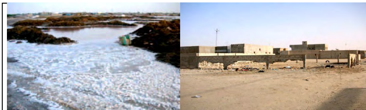
陥没部と塩水の例
