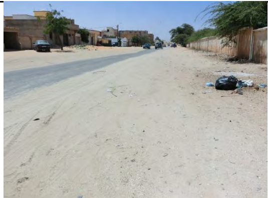
市内の道路状況（舗装部分が低い場合が多く、排水溝が無い ため降雨時には路面が浸水し易い）
