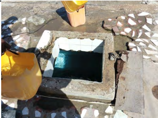
貯水槽(蓋が脇にあったが壊れていた)
