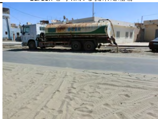
ONAS の衛生車による既設システムへの投入
