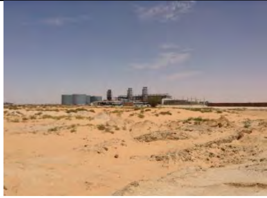
ヌアクショット市北部で建設中の火力発電所 (2016年中の竣工予定)
