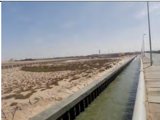
ヌアクショツト港の北側の防波堤。 北側からの海砂が堆積している
