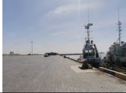
ヌアクショツト港の新埠頭（2014年に建設）と タグボート。ガントリークレーン等の荷役施設 は、整備されていない
