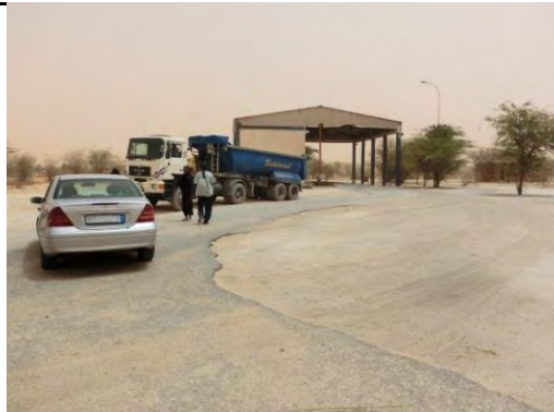
搬入トラック計量装置建屋（CET）
