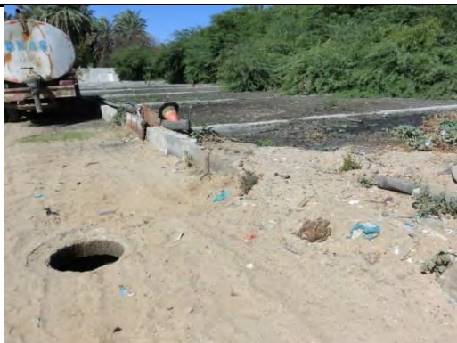
汚泥乾燥場（上部）
