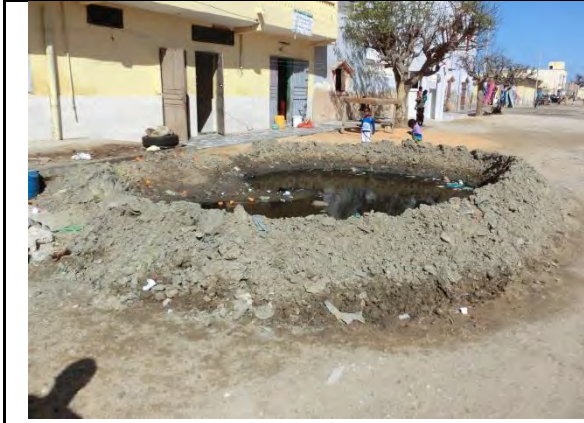
家の前の道路端に設けた下水溜め (Sebkha 地区)
