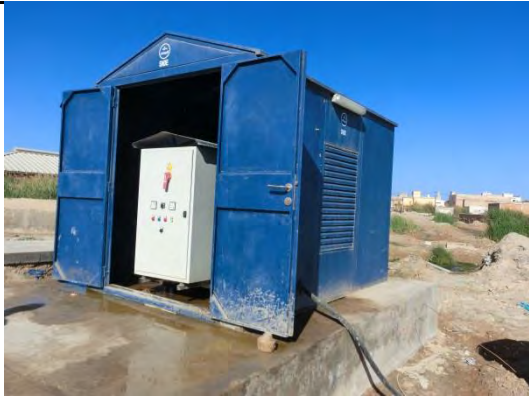
SNDE ポンプ場（基礎が嵩上げされている）
