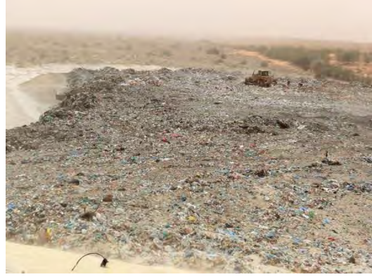
ブルドーザーによる最終埋立て
