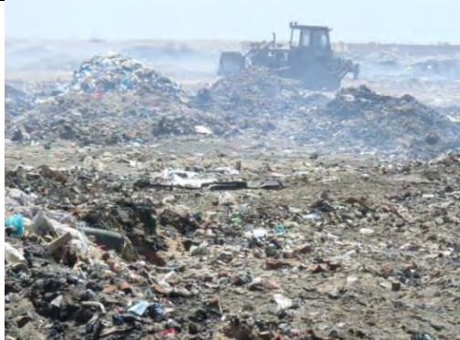
中継集積地における煙の中での敷均し
