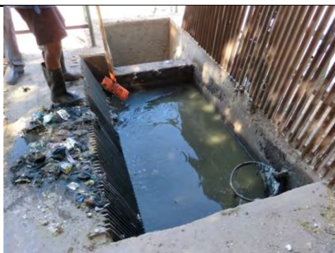
既設下水処理場受水槽
