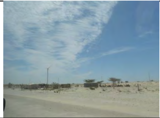
ヌアクショット市南部で建設中の風力発電施設 (30MW)
