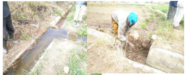
灌漑水路及び分水ピット 灌漑水は土砂を使って分水している。
