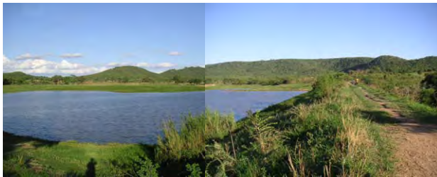
チパパ灌漑スキーム：貯水池及び堤体
