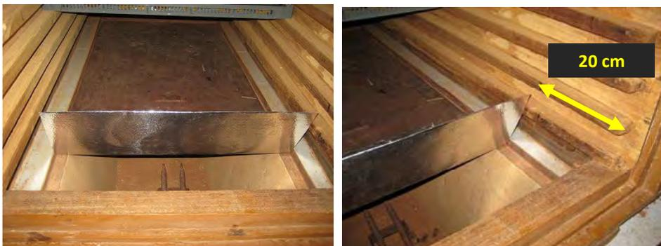
2. Couper le morceau d'aluminium et le fixer sur le diviseur existant .Vous pouvez le fixer avec des vis ou des rivets.
