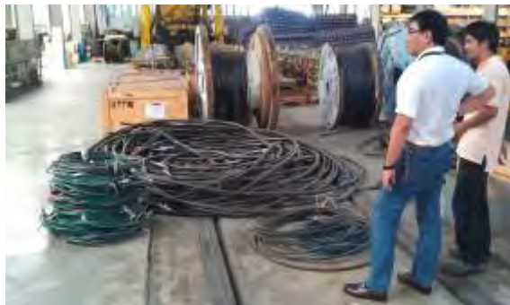
電気ケーブル
