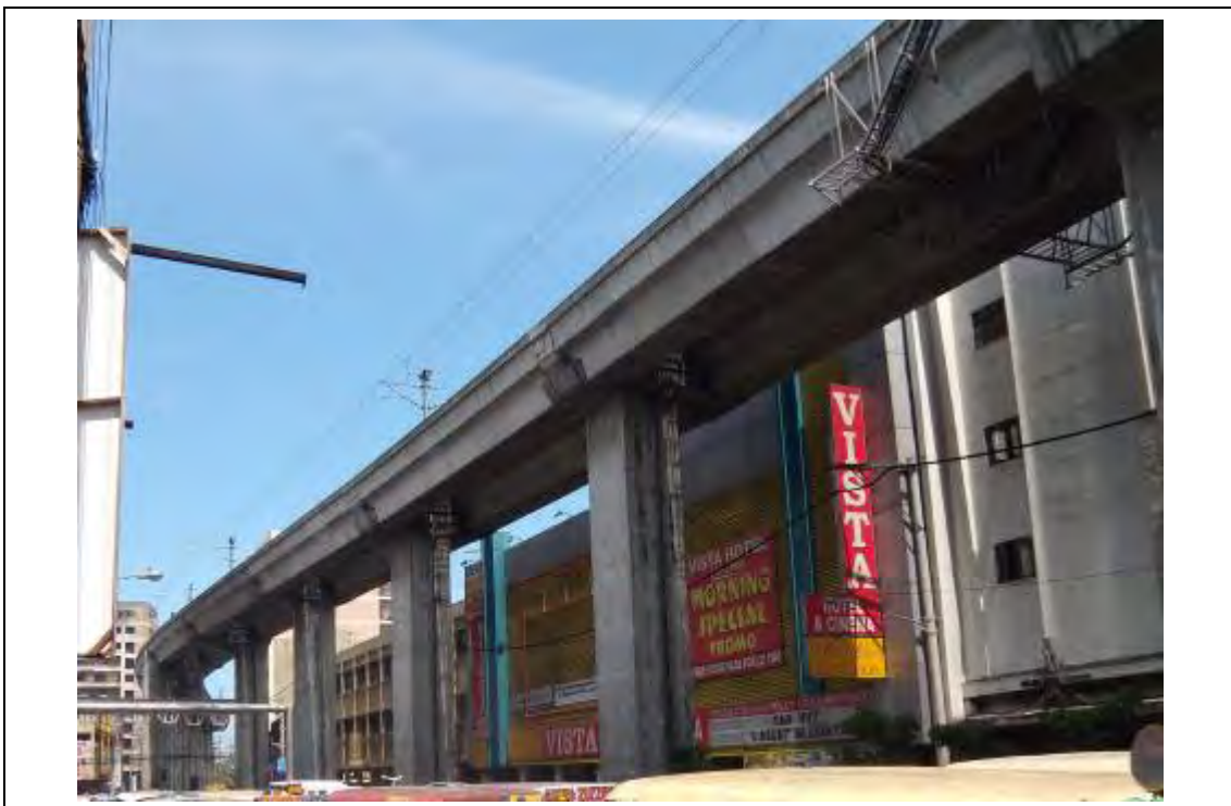
写真 3.7-1 C 箱桁 - 既設 LRT 2 号線桁 - マニラ
