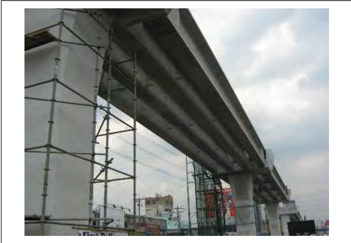
写真 3.7-2 AASHTO 桁 - LRT 1号線 延伸 (NEP) - マニラ
