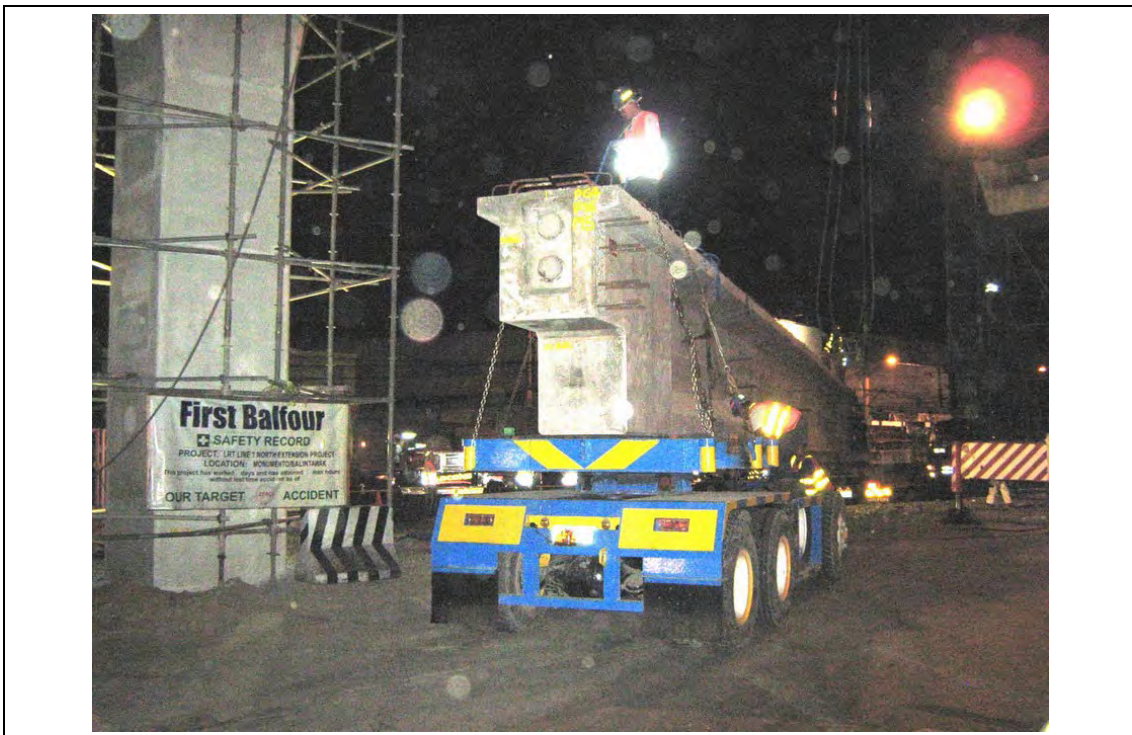
写真 5.1-4 LRT 1号線北側延伸プロジェクト - 桁をトラックで夜間に搬入
