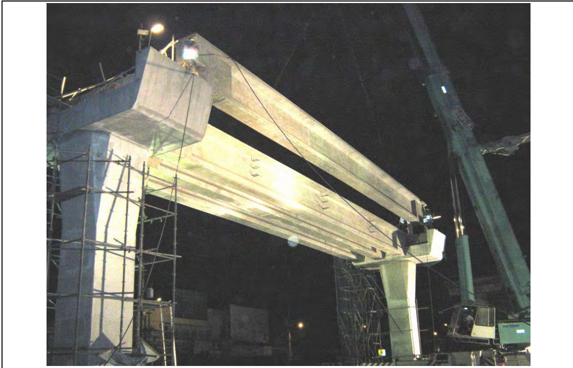
写真 5.1-5 LRT 1号線北側延伸プロジェクト ー 夜間にトラック・クレーン1台で架設される桁
