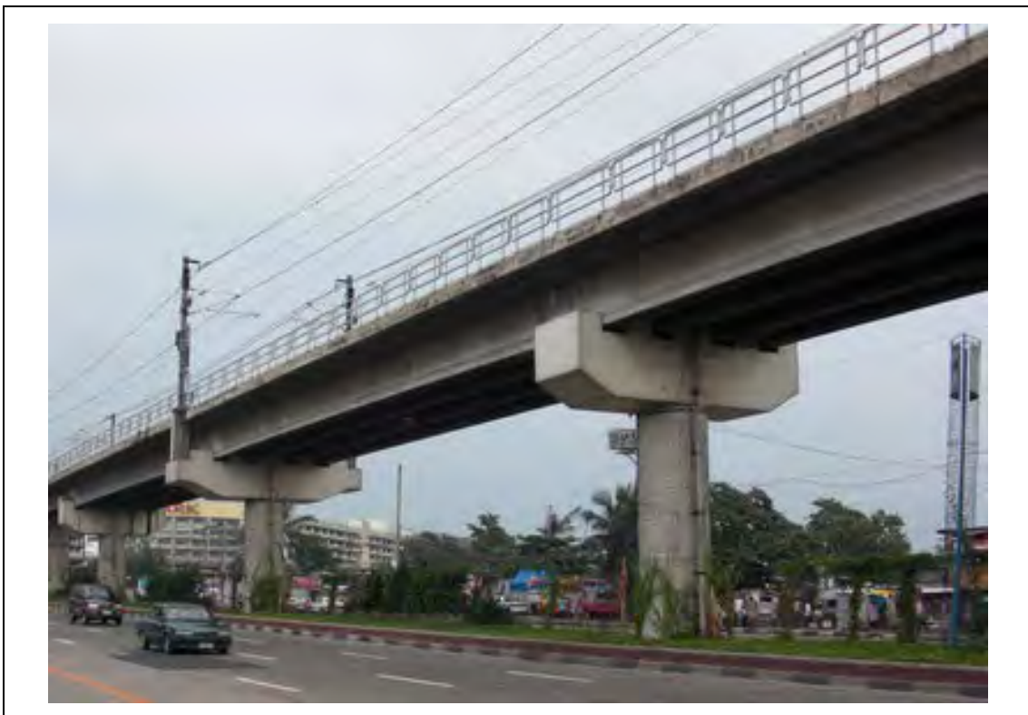
写真 3.7-3 AASHTO 桁 - MRT 3号線 - マニラ
