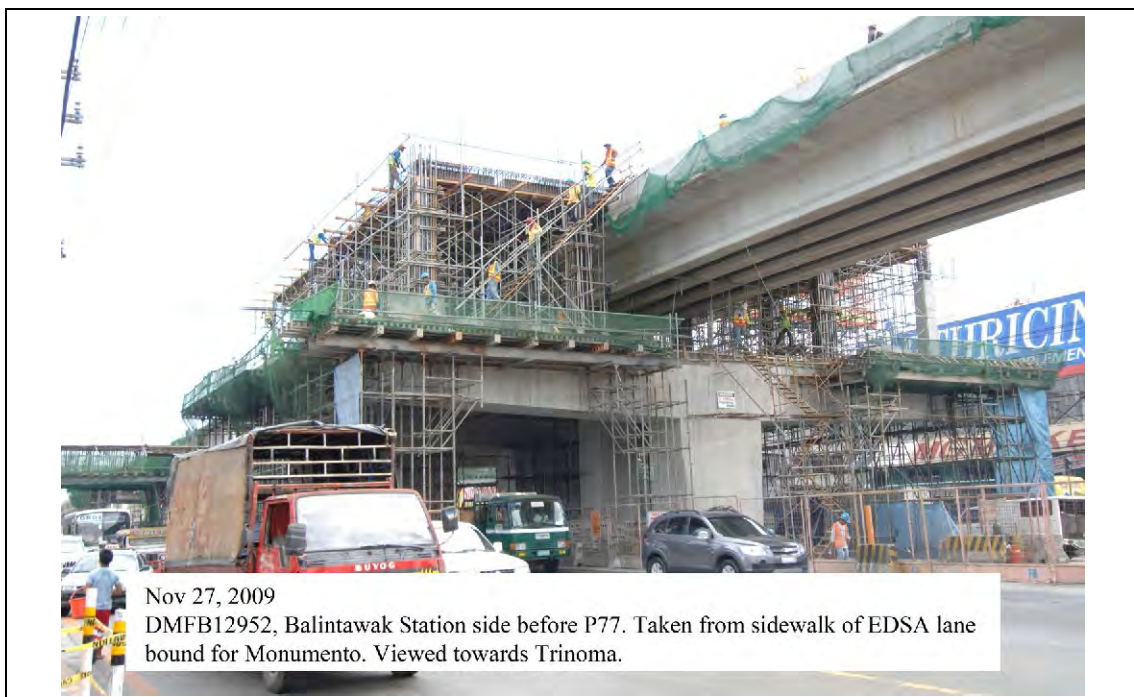
写真 5.1-7 LRT1 号線 NEP — 駅コンコースとプラットフォーム建設
