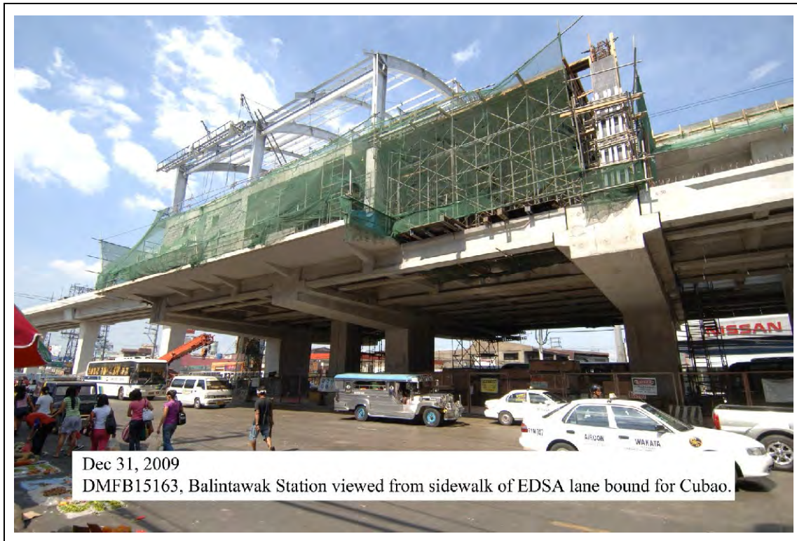
写真 5.1-8 LRT1 号線 NEP - 駅プラットフォームと屋根枠を建設中 Station
