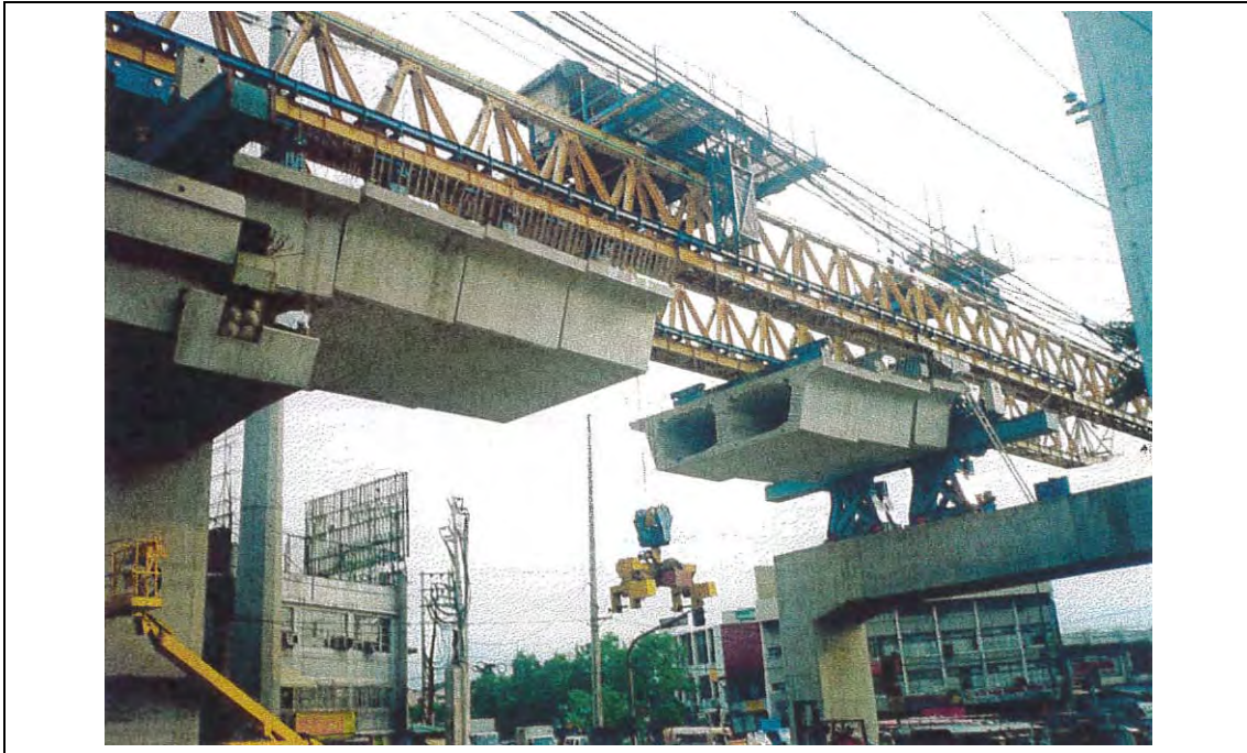
写真 5.1-3 二室箱桁橋の架設 - LRT 2 号線 (トラス式エレクションガントリー)
