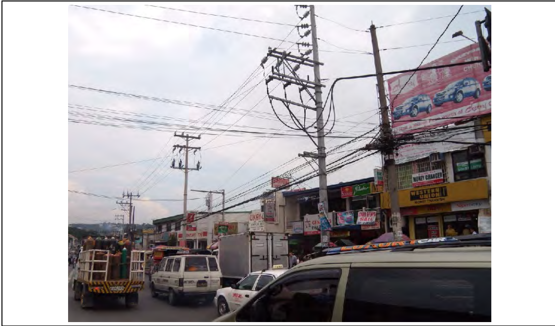
写真 5.1-10 東側延伸区間 — 高圧と低圧電線、電話線（マルコス・ハイウェイ道路端）
