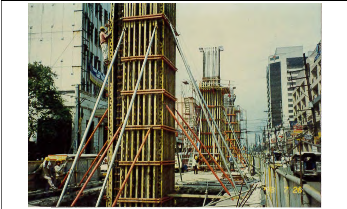
写真 5.1-1 橋脚支柱の建設 - LRT 2号線
