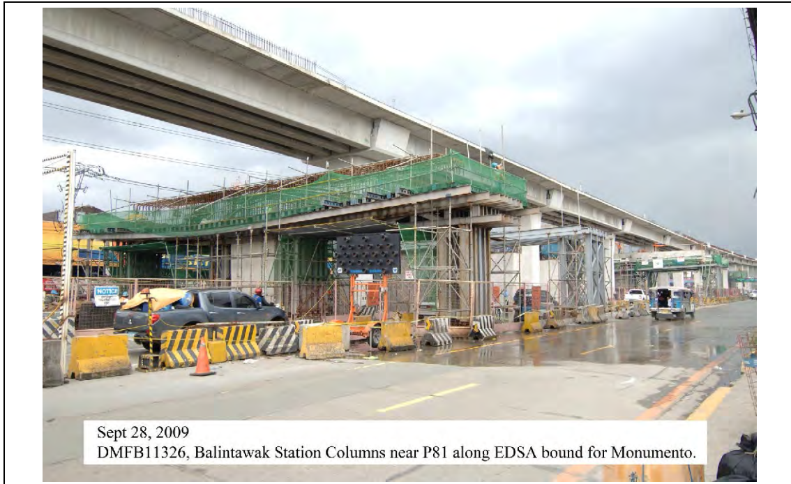
写真 5.1-6 LRT1 号線 NEP — 駅カンチレバー工法による橋脚建設
