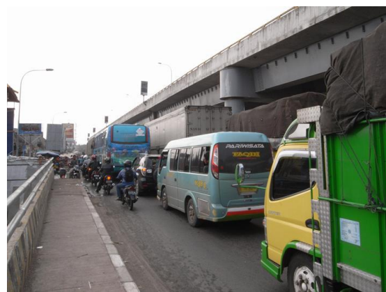
写真 2. ゲバン高架橋下のピーク時間帯の混雑（前方の魚市場前から続いている）
