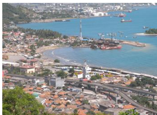
メラク高架橋の遠景
