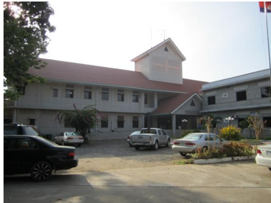
コンポンチャム州病院外科・産婦人科病棟
