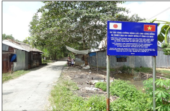
建設道路 (ウミン郡グエンフィッチコミュニティ)
