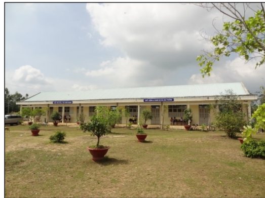
写真3：建設された小学校校舎 (ラムグーチュオンI小学校)
