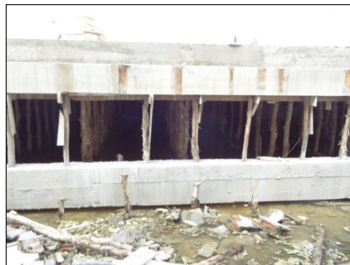
写真 4：鉄筋コンクリートを支える メラルーカ建材
