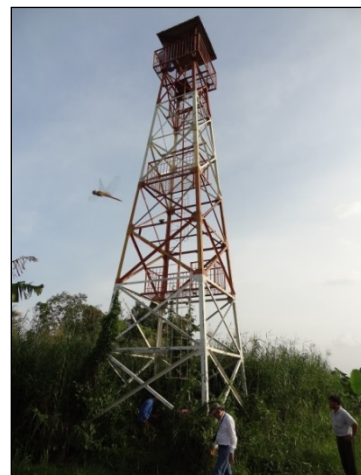
写真 2:建設された森林火災監視タワー（ウミンハ国立公園）
