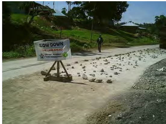
補修作業の様子（セクション 2）
