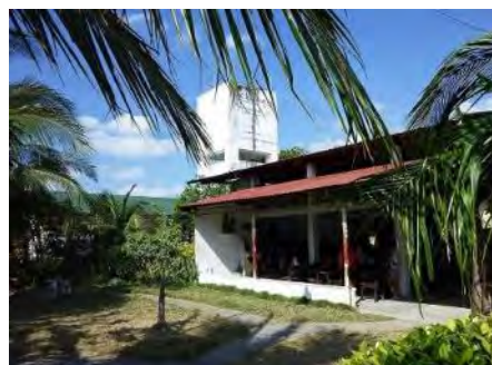
写真4 ソオック地区にて整備された施設 (手前は教会、奥は給水塔)
