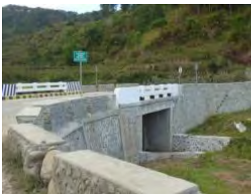
写真 3：本事業で整備された橋梁 （サバンガン近郊）
