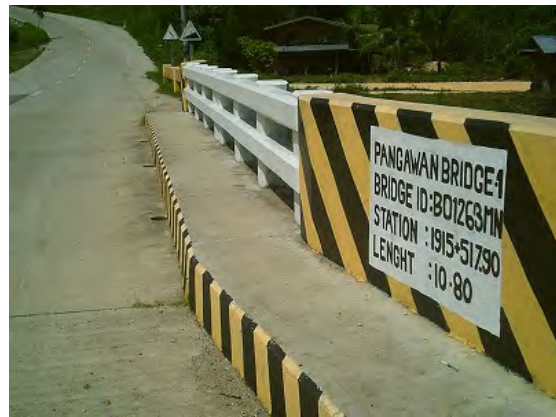
セクション3の橋梁1
