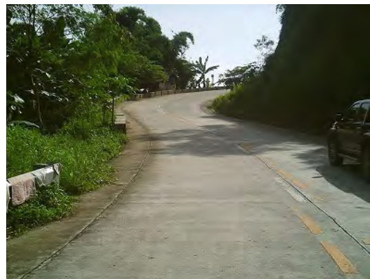
セクション 3 (マギンダナオ州とスルタン・クダラット州の州境～カラマンシグ)
