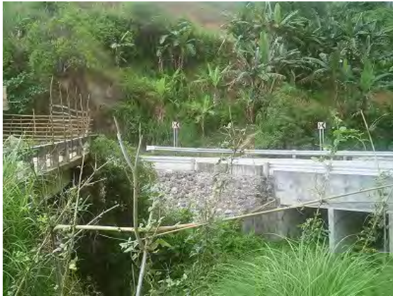
左の古い仮設橋を廃止し、新たにボックスカルバードで対応したルート（セクション2）
