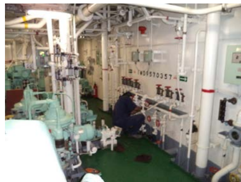
写真 4 機関室の点検状況
