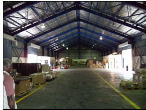
写真3 整備したバラ荷貨物倉庫
