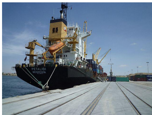
写真4 3B岸壁接岸状況
