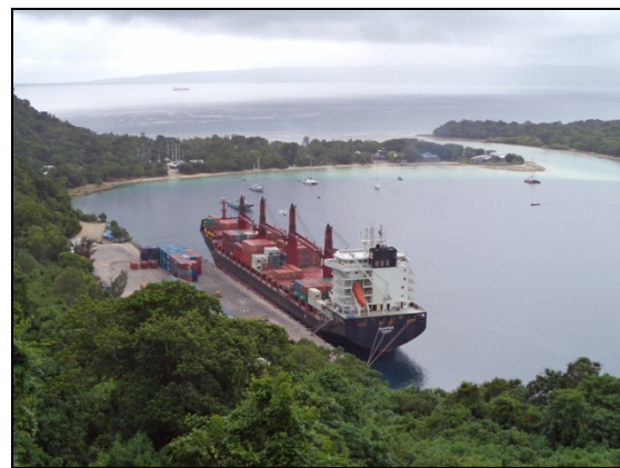
本事業で改修した埠頭と寄港貨物船
