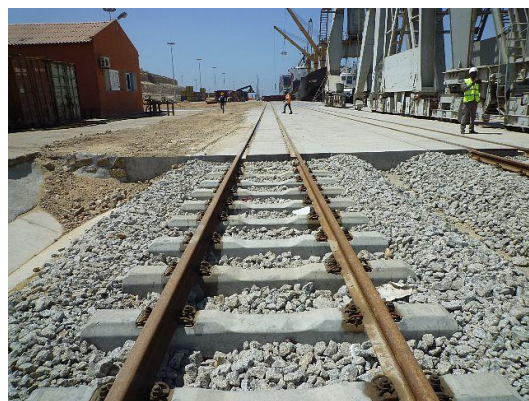
写真 11 軌道 3B 岸壁接続部分
