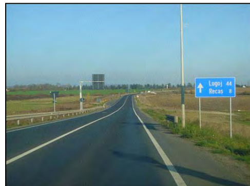
ティミショアラ〜ルゴジ区間道路 （2車線区間）
