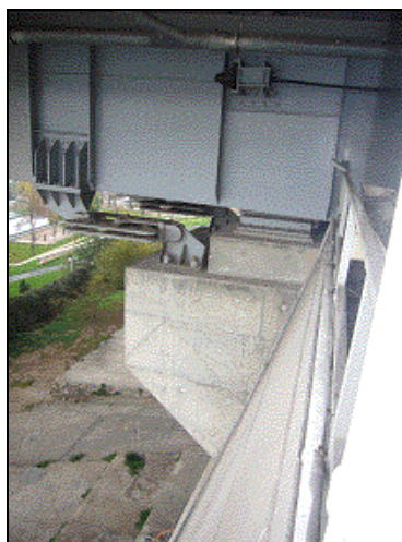
第1ボスポラス橋 アバットメント支点補強
