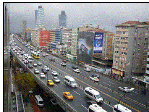
メジデキョイ高架橋
