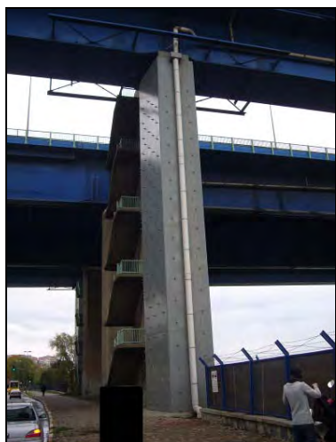
ゴールデンホーン橋 新橋 橋脚補強（鋼板巻き）
