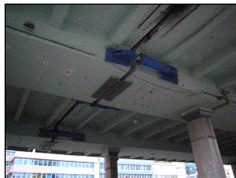
メジデキョイ高架橋 ダンパー設置
