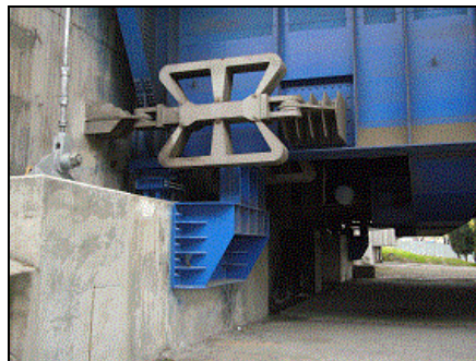
ゴールデンホーン橋 ダンパー設置 5
