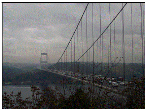
第 2 ボスポラス橋 全景
