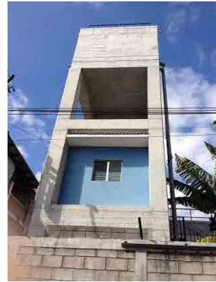
サン・フランシスコ配水区の配水池
