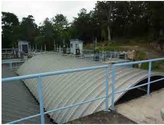
ピカチョ浄水場に増設された沈殿池・ろ過池
