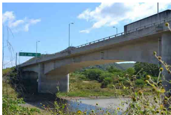
日本・中米友好橋
