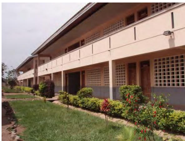
本事業で整備された校舎
