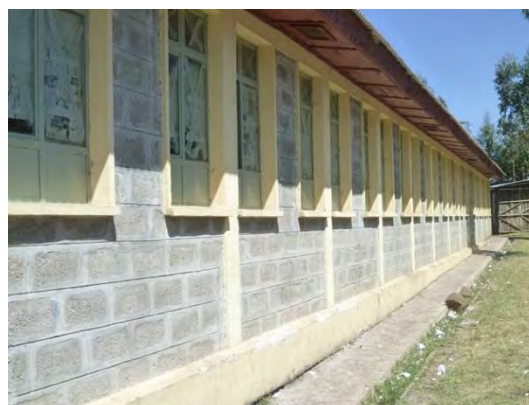
本事業で整備された校舎
