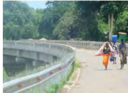
新設された橋（シュエザ橋）
