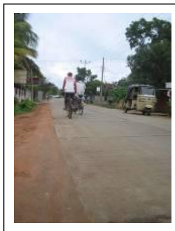
(本事業により復旧された道路)
