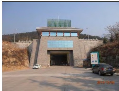
写真 1：泰安揚水発電所の地下発電所入口
