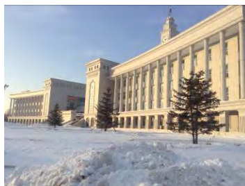
この建物の一部を追加アウトプットとして建設し、実験設備共用プラットフォームを設置した。 （ハルビン師範大学）
