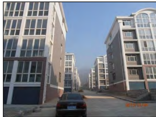
写真 3：常家村開発地域
