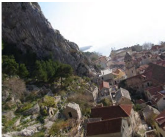
オミシュ市（スプリット）の 落石現場
