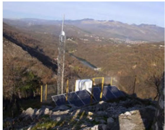
グロホボ地すべり地（リエカ）の モニタリング設備
