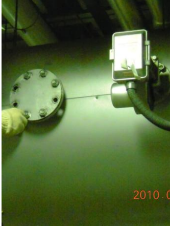
Lắp đặt lỗ thăm khí tại Ống dẫn và Ống khói
