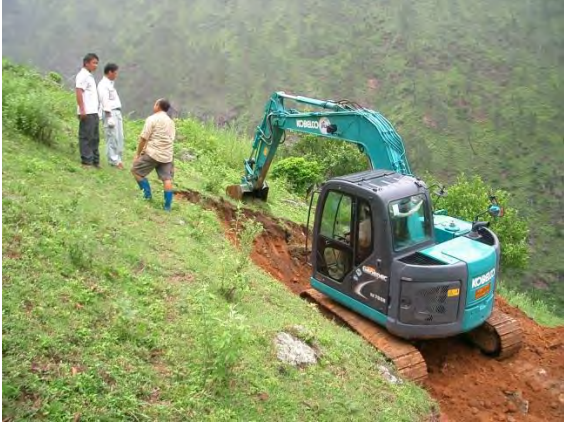
農道敷設（ルンチ県）
