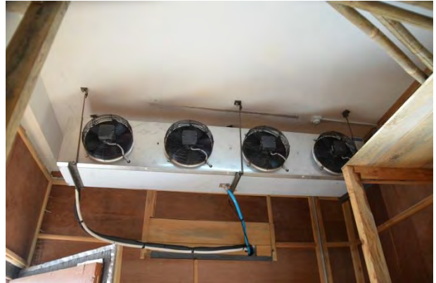
簡易保冷库（断熱材は機材の梱包材を利用）
