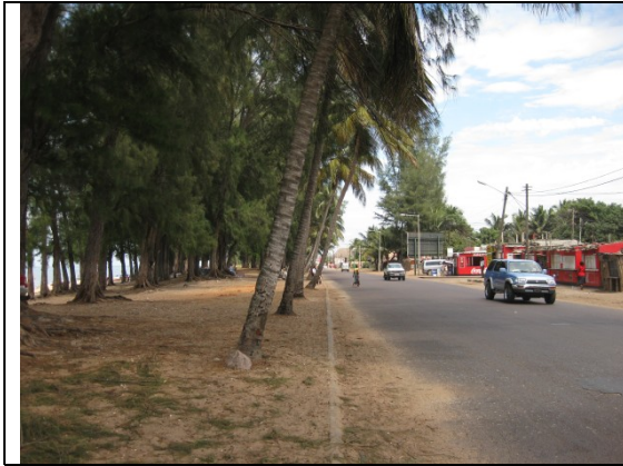
サイト前面の状況 幹線のマージナル道路に面する。
