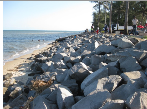
サイト北側の一部の海岸線 護岸整備がされている海岸もある。
