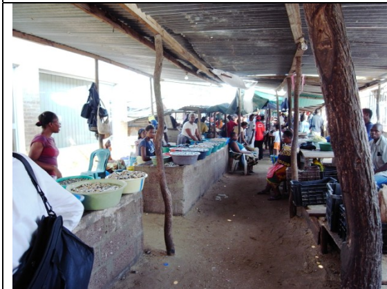
既存ア・ルタ・コンティニューア市場 場内は地面が露出し、排水路もなくして非衛生である。
