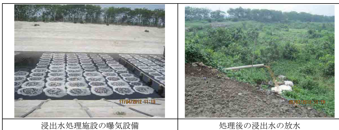
図 3.8-1 マトワイル処分場の現状
