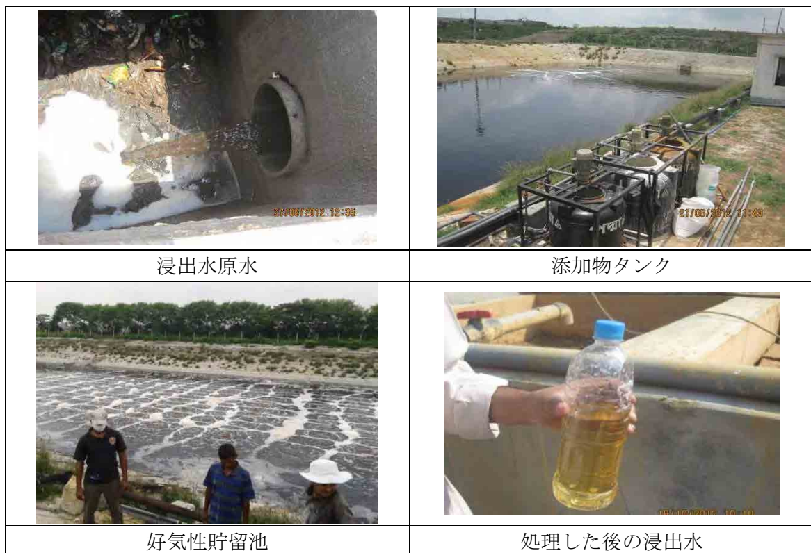
図 3.8-4 浸出水処理施設の概観
