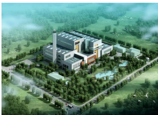
図 1-16: 青島都市廃棄物焼却発電所
