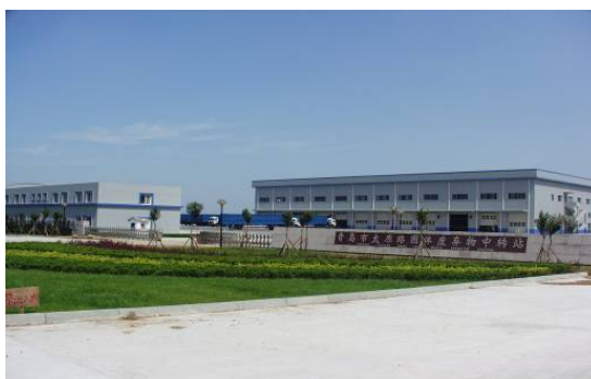
図 1-13: 太原路の大型の都市廃棄物中継輸送ステーション
