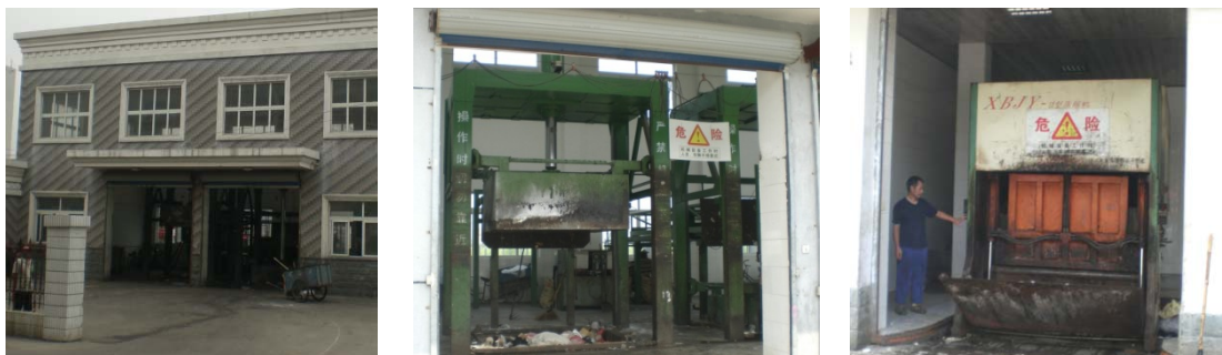
図 1-13: 圧縮式ごみ中継ステーション
