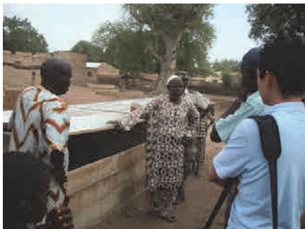
改良型堆肥製造施設
