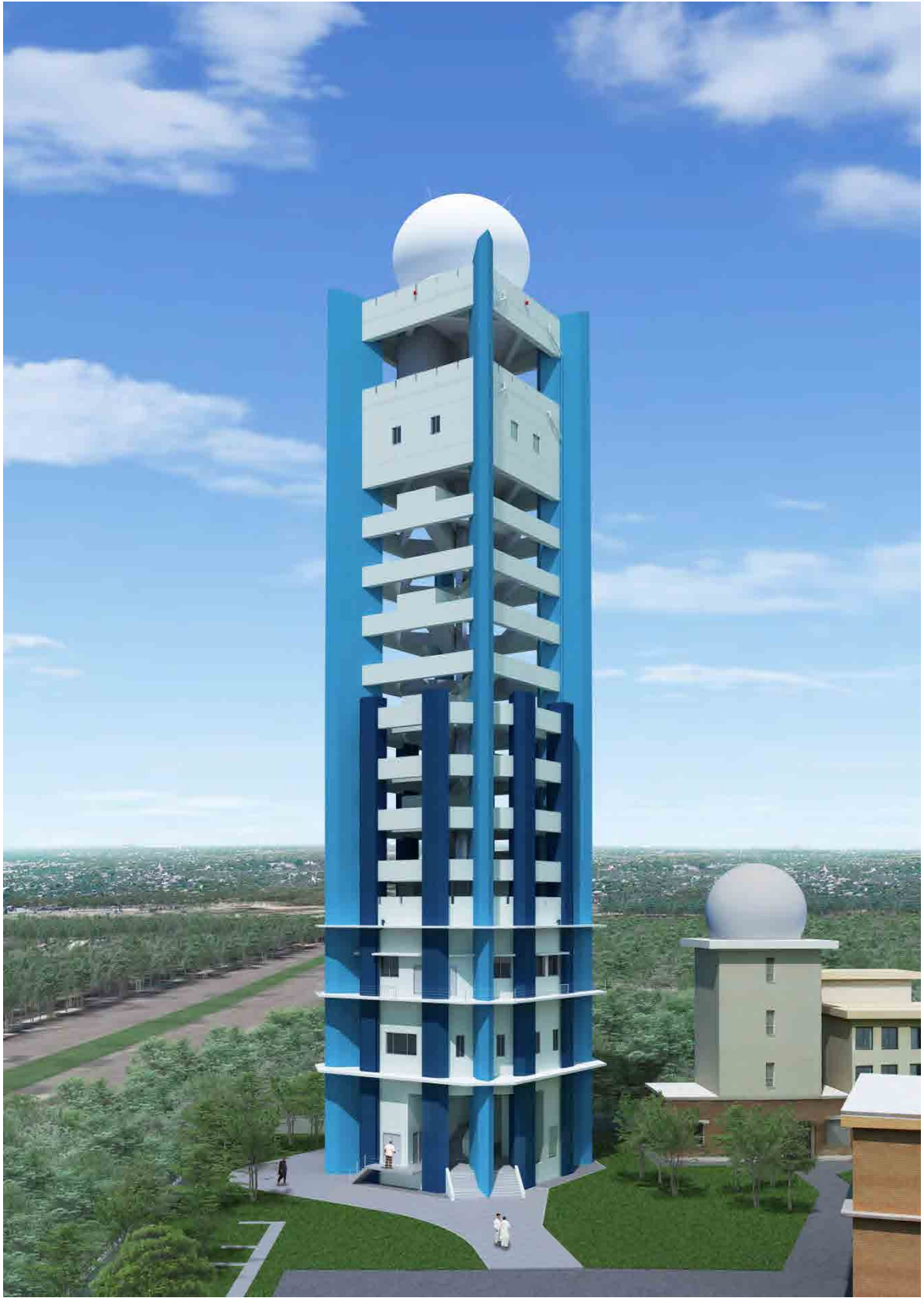
イスラマバード気象レーダー塔施設
