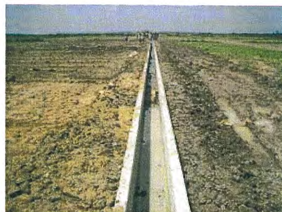
〔完成後の施設(同左)〕
