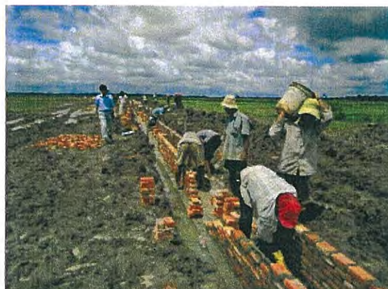
〔農民参加型建設活動の例(トムネ地区)〕
