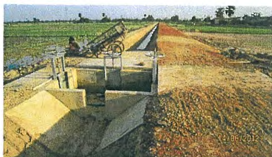
〔完成後の施設(同左)〕
