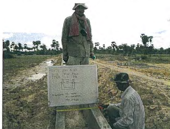
〔出来形管理の実施(スアオム地区)〕
