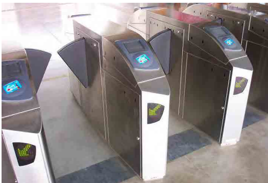
図 7.15 格納式フラップタイプのコントロールゲートの例
