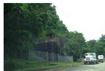
切土が発生する 2 km 700 付近の丘 (Cerro Sosa)
