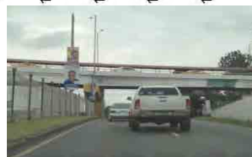
路線の上空を交差するフライオーバー
