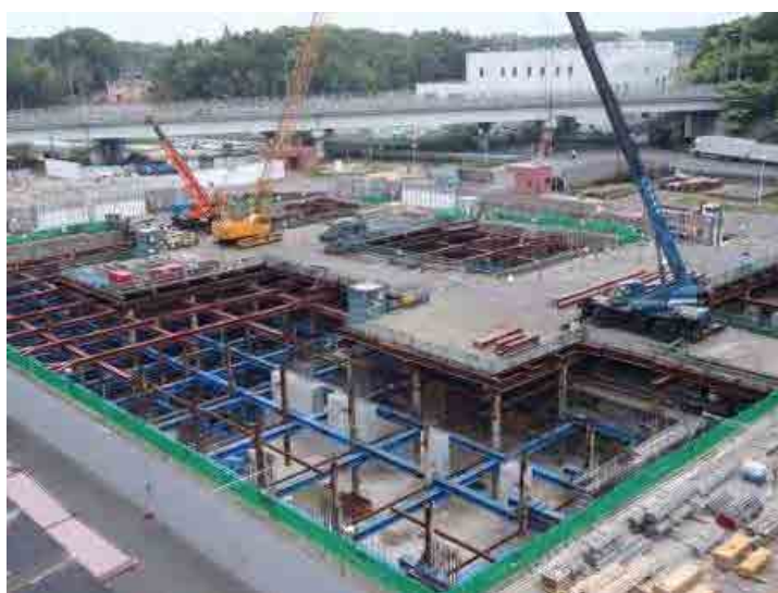
図 3.16 Central 配水池の土留め計画イメージ
