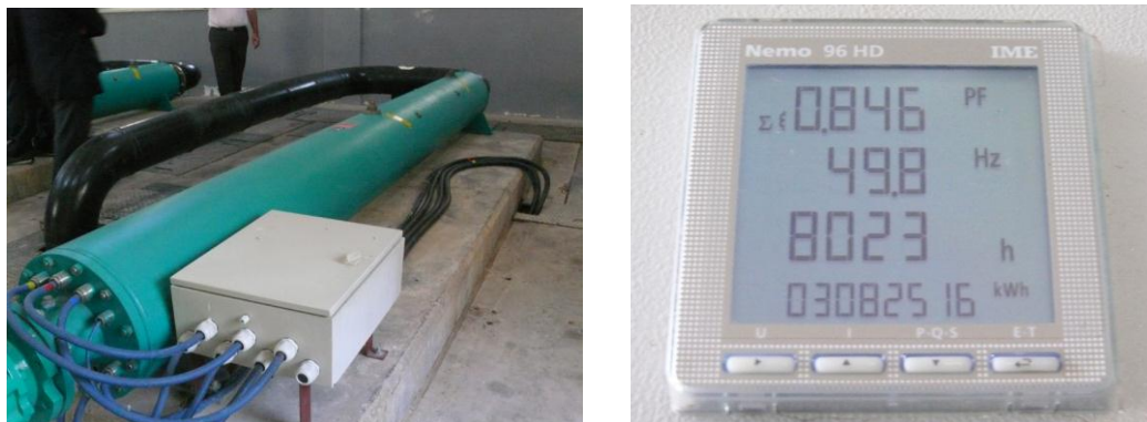
図 45 水中ポンプと力率・周波数・積算電力使用量表示
