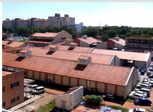
本事業で整備された施設
