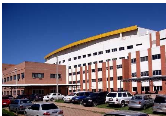
中間棟（左）・入院棟（右）
