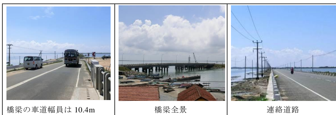
新マナー橋と整備後の連絡道路
