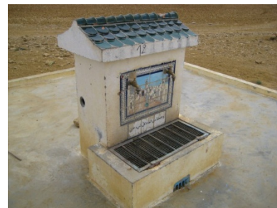
公共水栓 (Ghanzour 村、ケロアン県)
