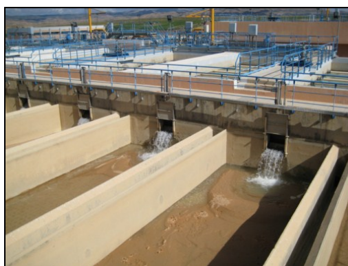
ウジュダ浄水場
