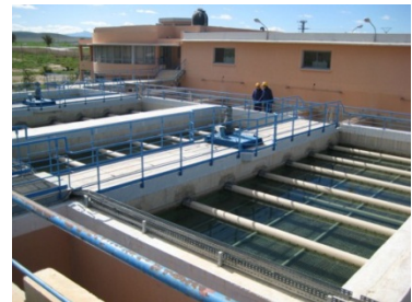
ウジュダ浄水場
