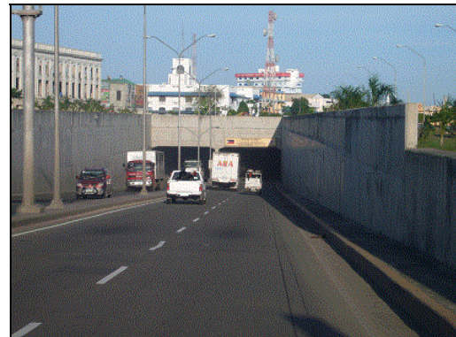
海岸道路 トンネル区間
