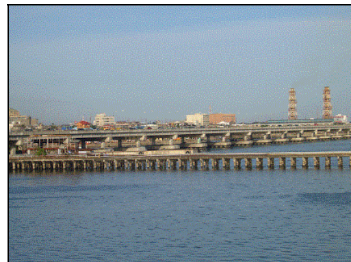
海岸道路 高架区間
