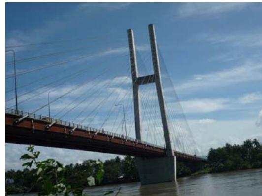
第二マグサイサイ橋
