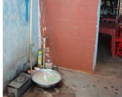
住居兼飲物屋に設置された水栓とメータボックス。住居部分に井戸があるがトイレに隣接しているため使用をやめた。住人による使用だけでなく店の食器を洗ったり、客が手を洗うことができる。
