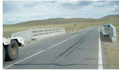
（写真）建設されたフッサーナリン橋
