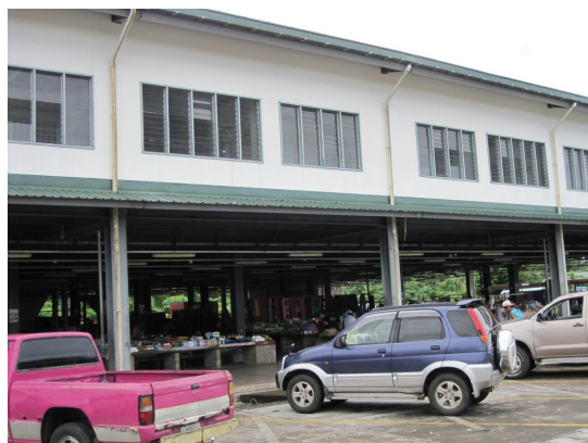
写真4 開発された地区に移転した新マーケット
