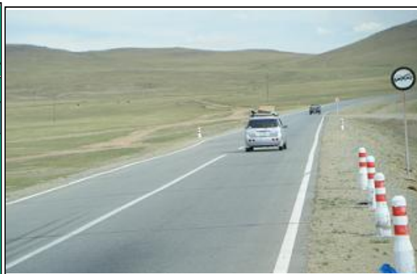
本事業で整備した道路
