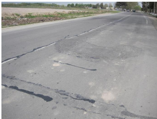
写真 4 損傷後補修された路面（第 1 期区間：路面が波を打っており、中央線も曲がっている）
