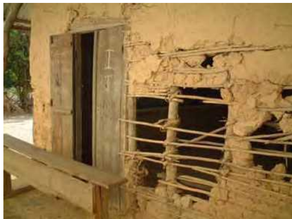
コミュニティによる土壁の教室
