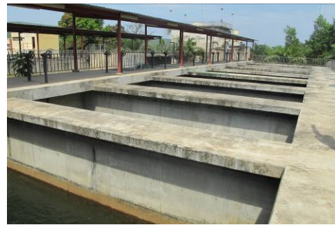
イエスル第3浄水場 (急速濾過池)
