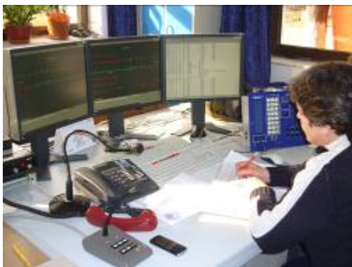
CERNAVODA POD 運行システム施設
