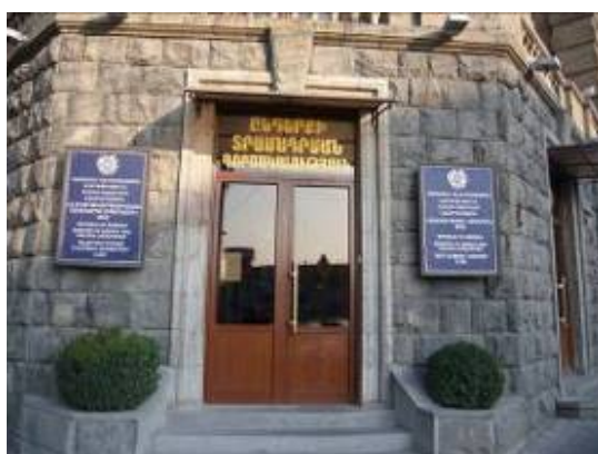
EPSO 及び解決センターの入っているビル
