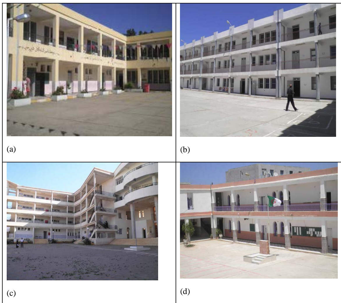
Figure 4 quelques établissements scolaires reconstruits
