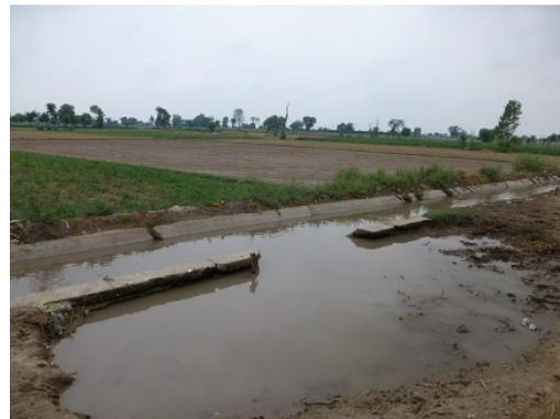
図 9. 壊れた末端水路の例
