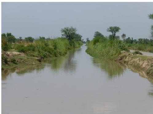
図 8. 未補修の支線水路の例
