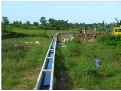
図 12 : 3 次水路のコンクリート・ライニング化
