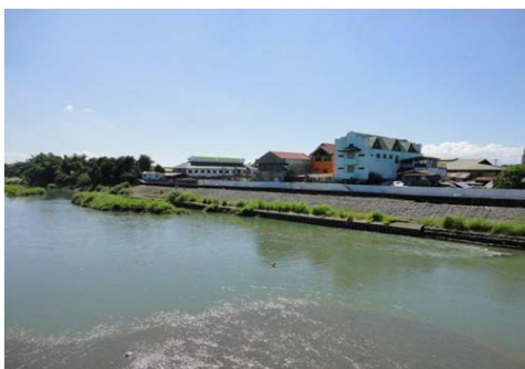
河川改修後のアグノ川
