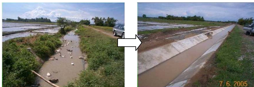
図 3：2次水路の改修工事前・工事後の変化 12
