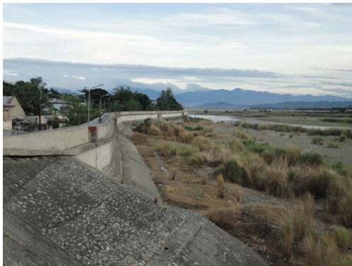
ラオアグ市内の護岸堤防
