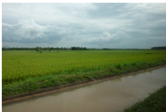
図 13：改修された幹線水路
