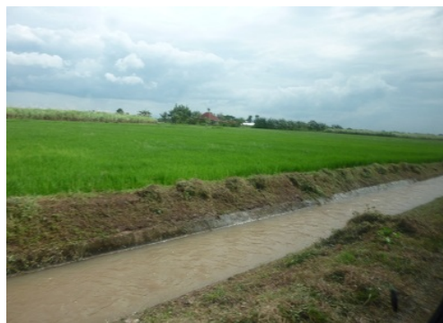
改修された2次水路
