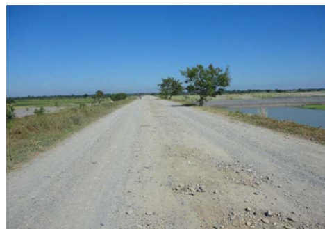
締切堤（堤防の上から撮影）
