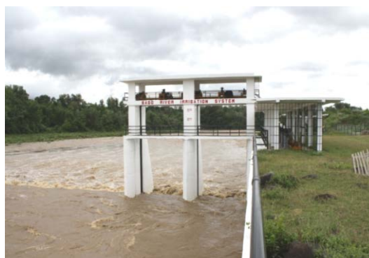
図 14：改修された頭首工とバゴ川
