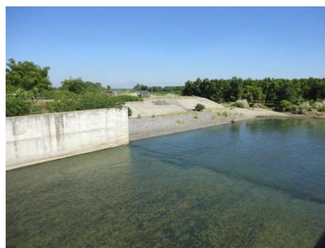
河川改修後のアグノ川
