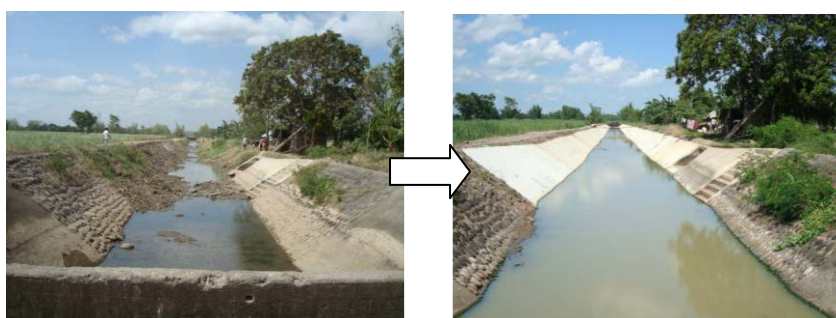
図 2：幹線水路の改修工事前・工事後の変化
