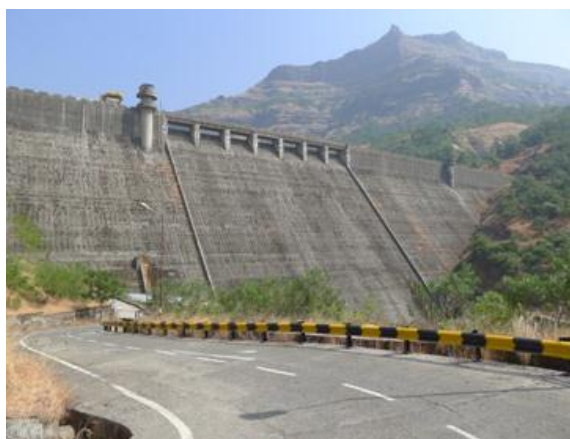
ガドガール揚水発電所
