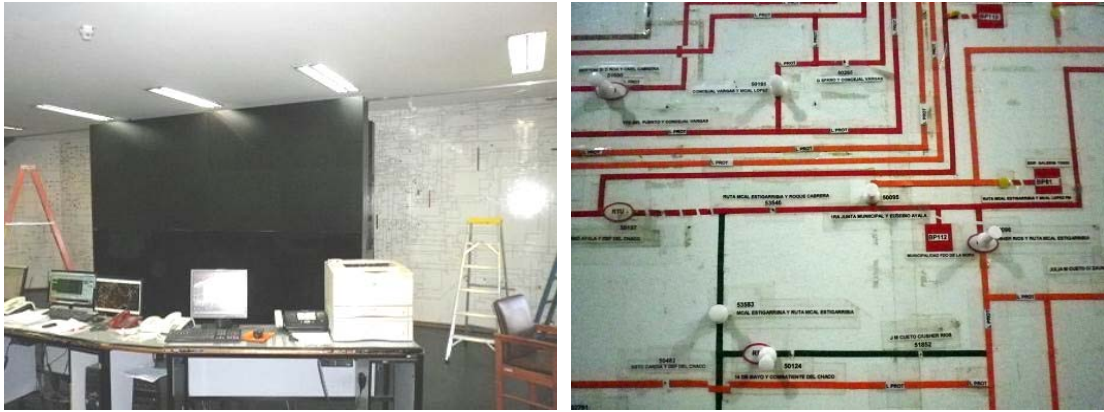
配電制御室（左：使われていない大型ディスプレイ、右：手動ディスプレイ）
