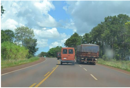
登坂車線（工区 5）
