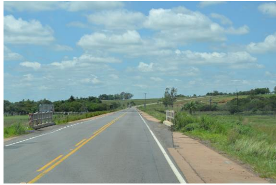
拡幅された橋梁（工区 5）
