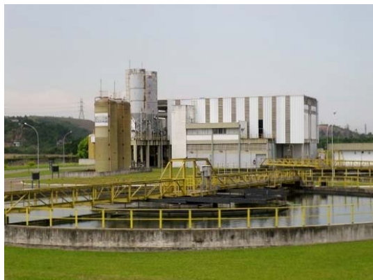
一次処理施設 (サラプイ処理場)
