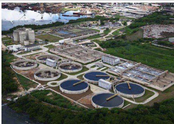
アレグリア下水処理場
