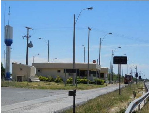
重量検査所（工区 7）
