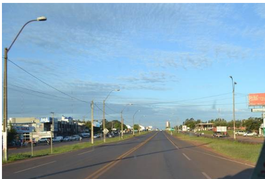
側道設置により沿線に立地した流通倉庫、修理工 場等の商工業施設（工区 10）
