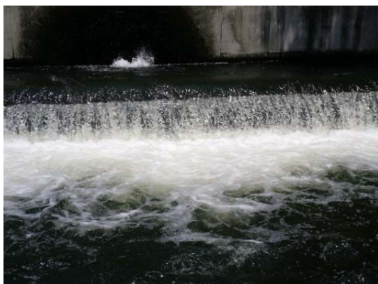
放流前の処理水 (アレグリア処理場)
