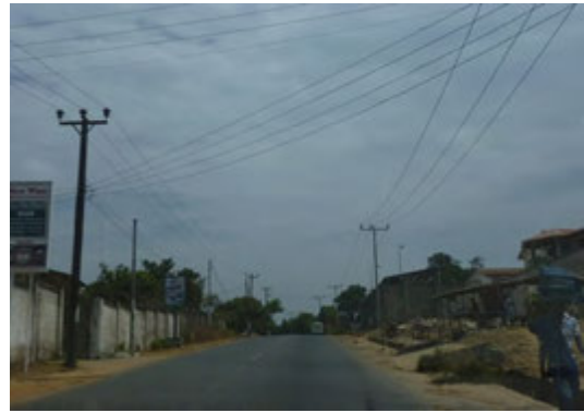
図4：ウィルバーフォース/リージェント間配電線（左側が11kV配電線、右側が33kV配電線）
