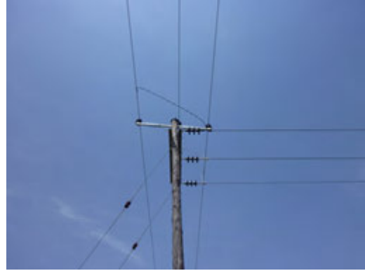
図 9：建設された 33kV 配電線 (東部イガンガ県イタンダ地区)
