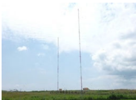
図 11：マワガ送信所のアンテナ・システム
