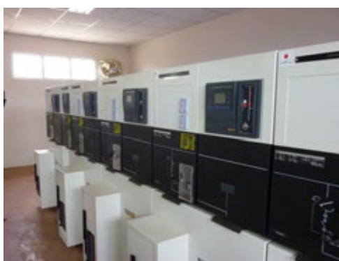
図14：配電制御室 （リージェント変電所内）
