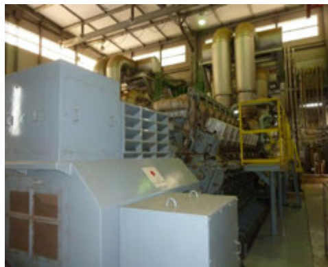
調達された発電ユニット (キングトム発電所)
