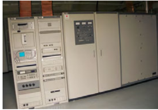
図 14：ケリバ送信所内にて調達・据付 された送信機材
