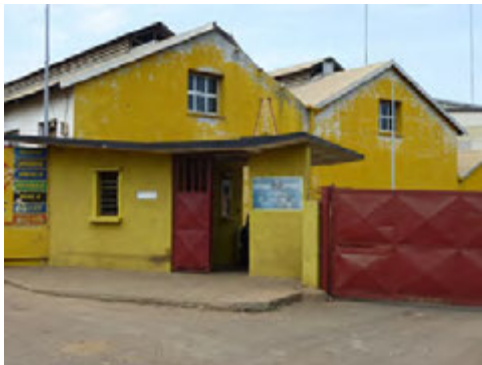
図 12：キングトム発電所外観
