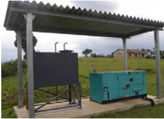
図 13：ケリバ送信所の非常用発電機 (左側はディーゼル燃料貯蔵タンク)
