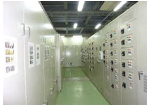
図 13：配電ユニット制御室 （キングトム発電所内）
