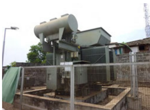
図15：調達された配電用変圧器 （リージェント変電所内）
