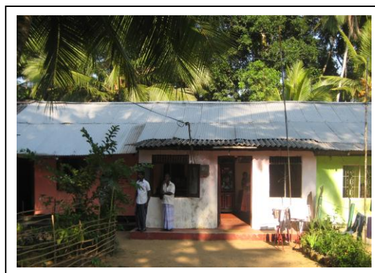
屋根の葺き替えが行われたラインハウス
