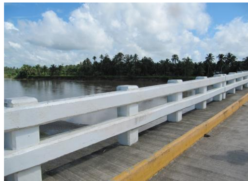
本事業により新規敷設された市場連結橋梁（アグサン・デル・スール州）
