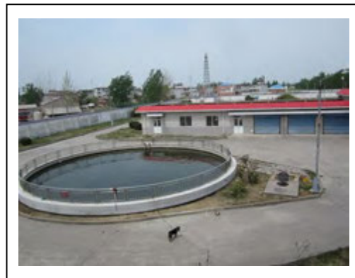
図 22 火災に備えた防水池 (淮南市)
