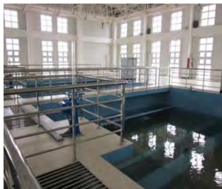
銅川市浄水場のろ過池
