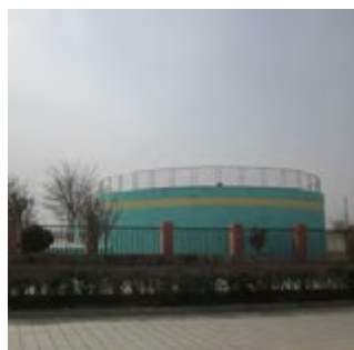
図7 配水場（白水県）
