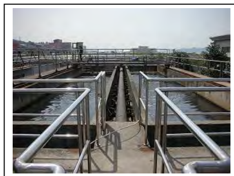
臨江溪下水処理場の沈殿池
