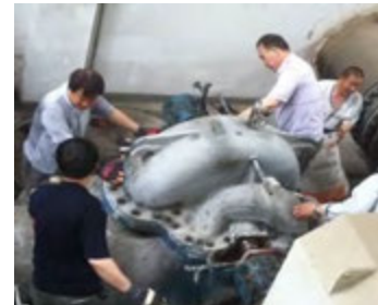
図13 冷却水循環ポンプ点検
