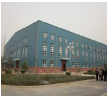
図6 建屋内設置の浄水場（銅川市）
