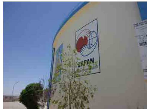
バトラウィ配水池
