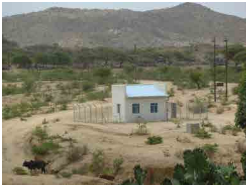
図 11：雷被害により電気系統が故障し 未稼働の井戸・ポンプ施設 (デケムハレ)
