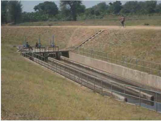
写真 3：新設された沈砂池
