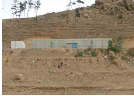
図 10：建設された配水池 (デケムハレ)
