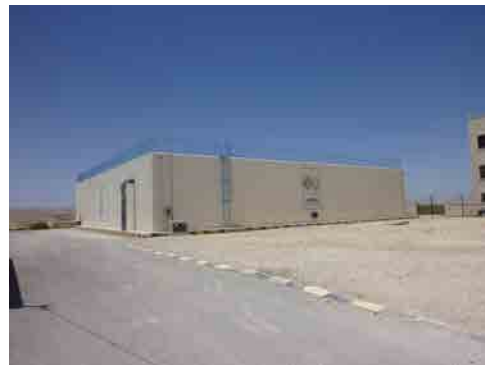
写真2：ザルカ市北部配水池
