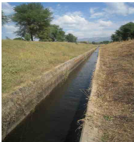
写真 1：移設された新規幹線水路
