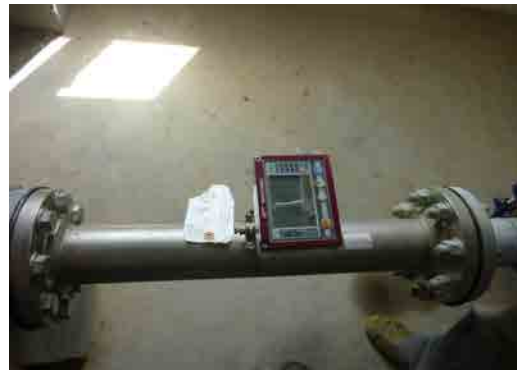
図 2：未稼働の水量計メーター（デケムハレ）
