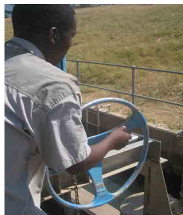
写真 6：沈砂池ゲート操作中の水管理人
