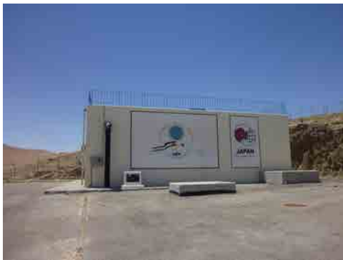
写真1：スフナ配水池
