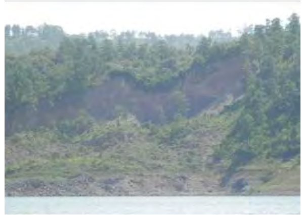
湖畔の崩壊地
