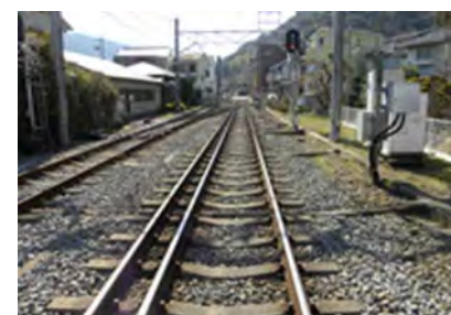
図 6.2-45 三線軌道の例
