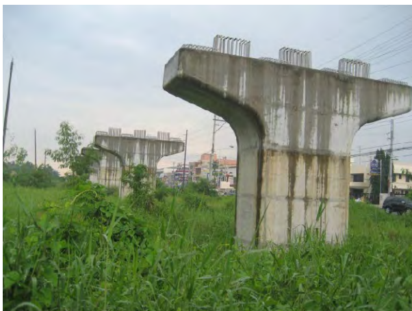
図 3.2-2 未完成の下部工（Guiguinto 付近）および放置された下部工（Calocan 付近）
