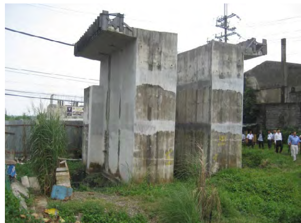
図 3.2-2 未完成の下部工（Guiguinto 付近）および放置された下部工（Calocan 付近）
