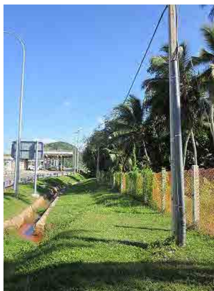
写真 2-1-1 光ファイバケーブル
