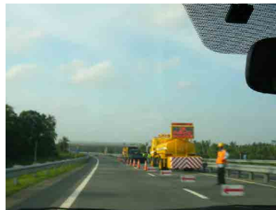
高速道路本線上の作業状況
