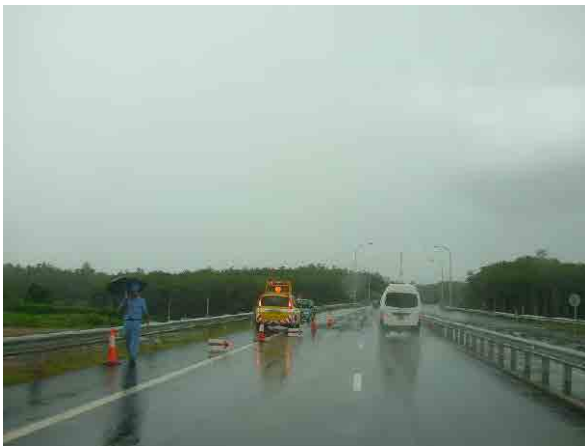
降雨によりスピニングして停車した車両の復旧作業
